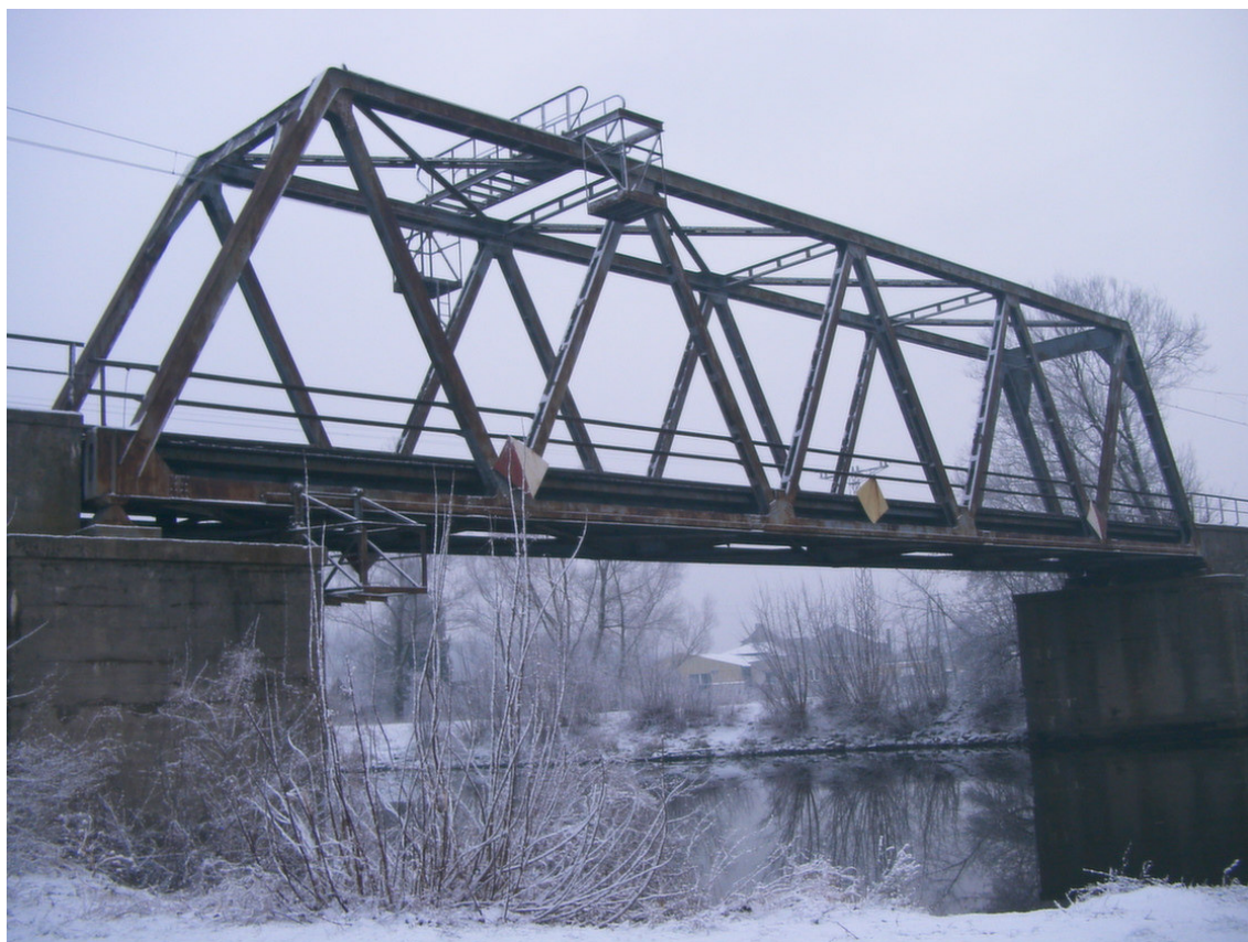
Rys. 8 Rzeczywisty obiekt mostowy do przyszłych testów
